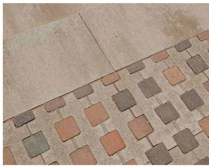
P-01 Paviment Breinco de llosa de formigó de 40x40x12cm + llosa de formigó de 8x8x6cm
