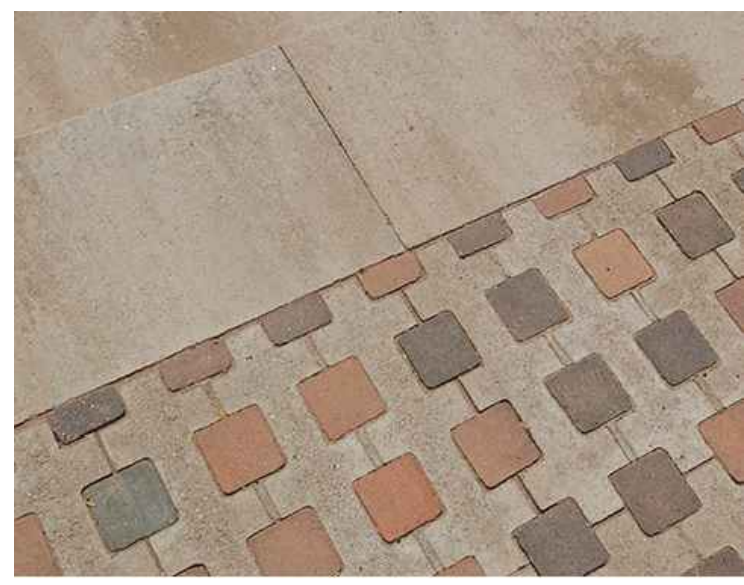
P-01 Paviment Breinco de llosa de formigó de 40x40x12cm + llosa de formigó de 8x8x6cm
