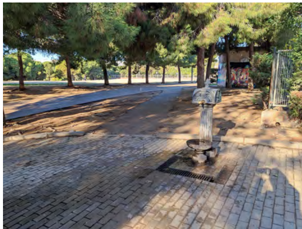
Font existent a l'av. Puigfred, on es connectarà la nova font
