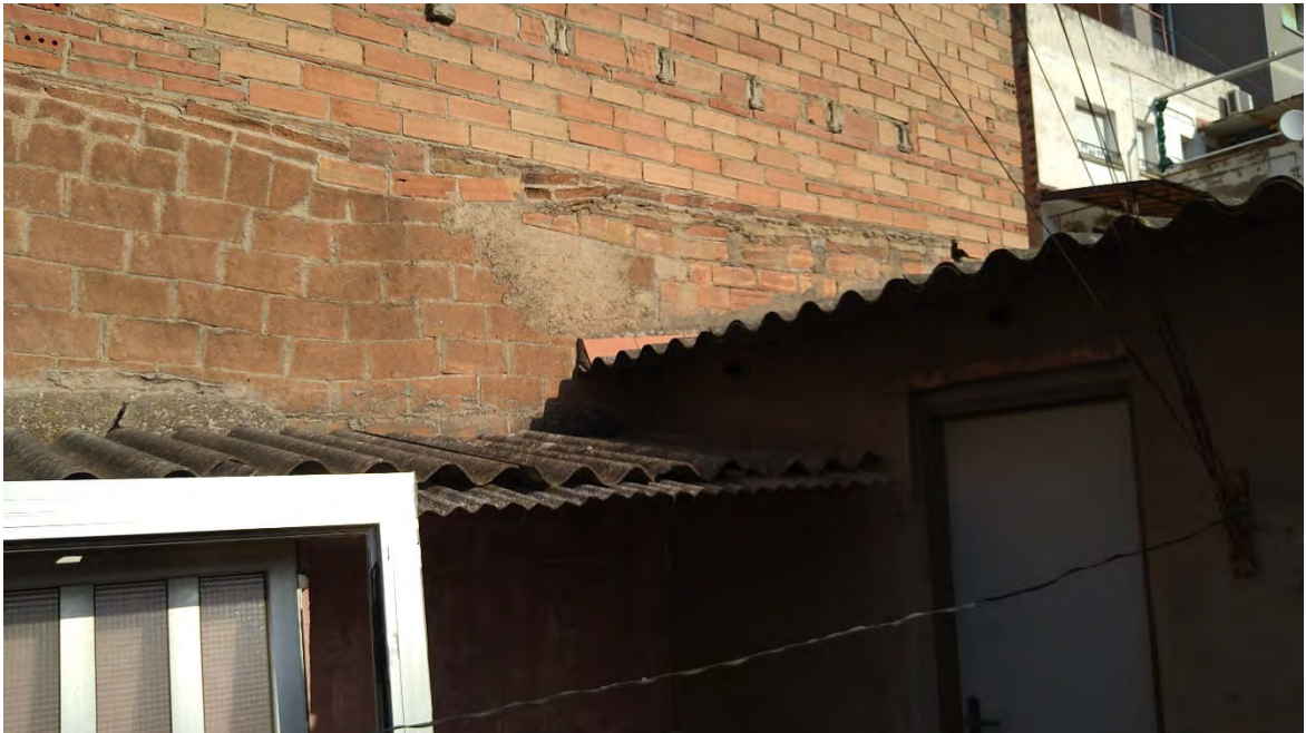
DETALL DEL COBERT LATERAL (MITGERA AMB M. BENLLIURE 38)
