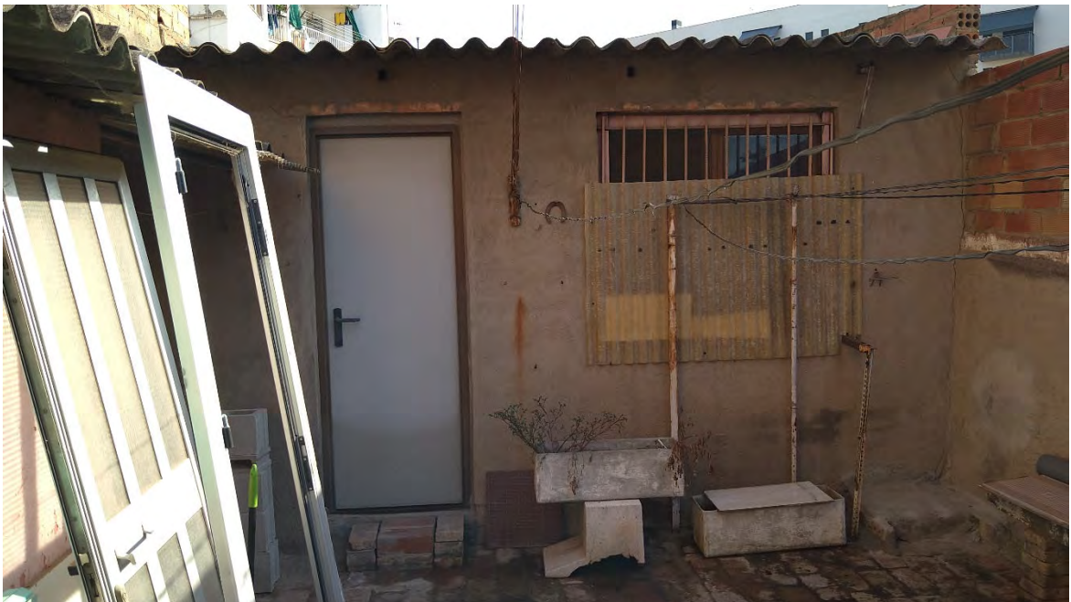
COBERTS AL FONS DEL PATI
