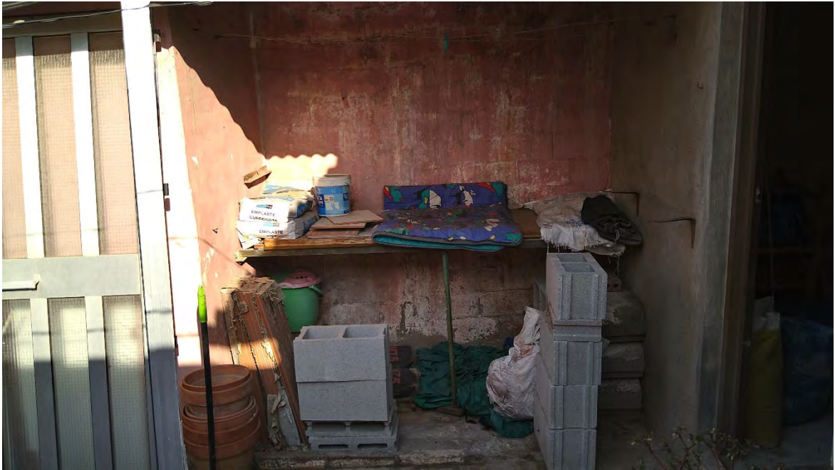
DETALL DEL COBERT LATERAL (MITGERA AMB M. BENLLIURE 38)
