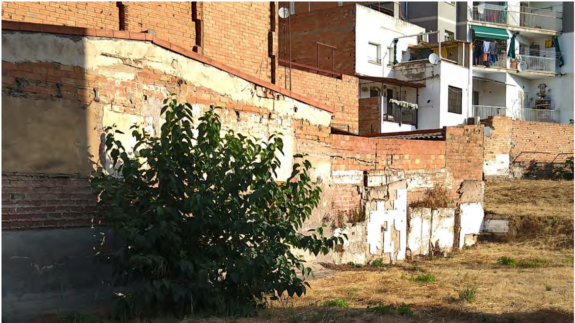
ASPECTE EXTERIOR DE LA FINCA
