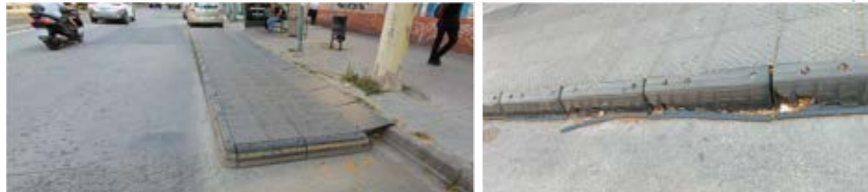
PLATAFORMA ACCESSIBILITAT PARADA BUS A DESMUNTAR I RE-INSTALAR. (RENOVACIÓ PECES MALMESES)
