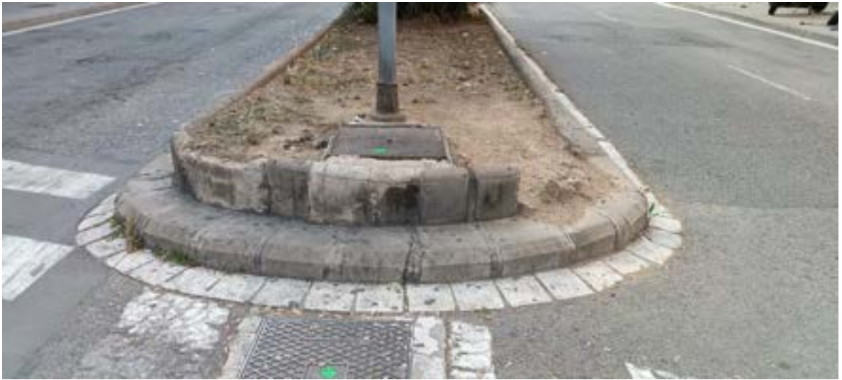
Vorada superior malmesa en gir mitjana central – a reparar. Rigola a extreure a substituir per asfalt.
