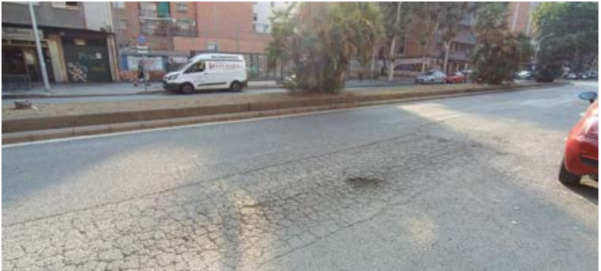
Costat sentit St. Adrià - Estat del ferm general a alçada pistes esportives i detall flonjall.
