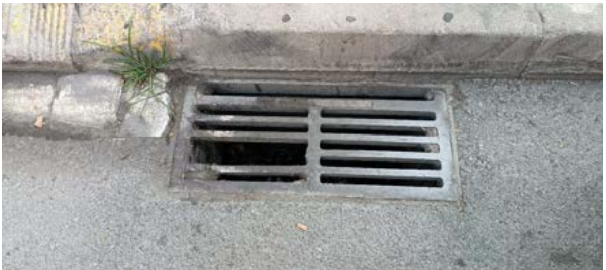
Detall reixa embornal malmesa a substituir o reparar.
