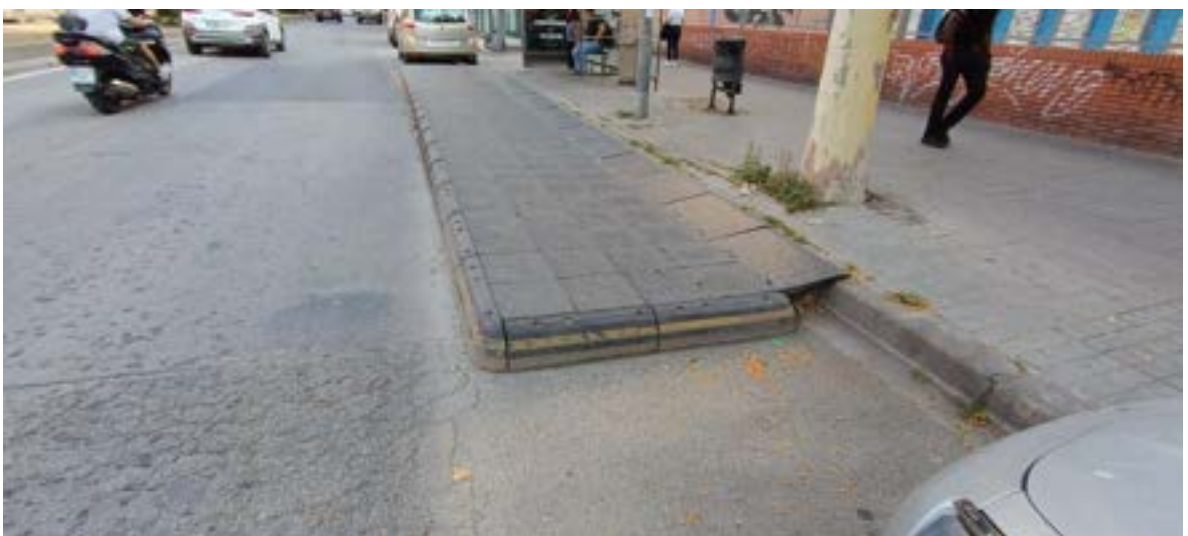
Plataforma modular d'accessibilitat a bus a desmuntar i re-instal·lar.
