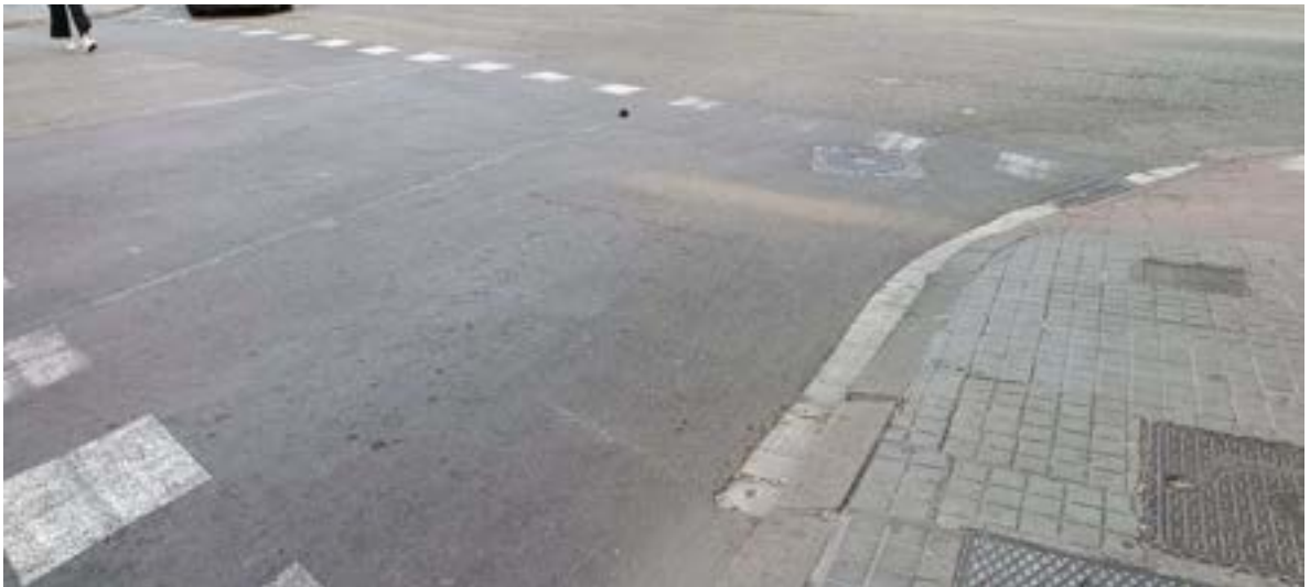
Vorada superior malmesa en gir mitjana central – a reparar. Rigola a extreure a substituir per asfalt.
