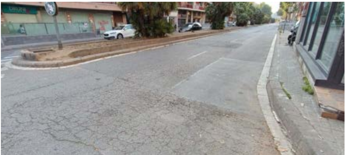
Costat sentit St. Adrià – vista estat del ferm, vorada mitjana en mal estat.
