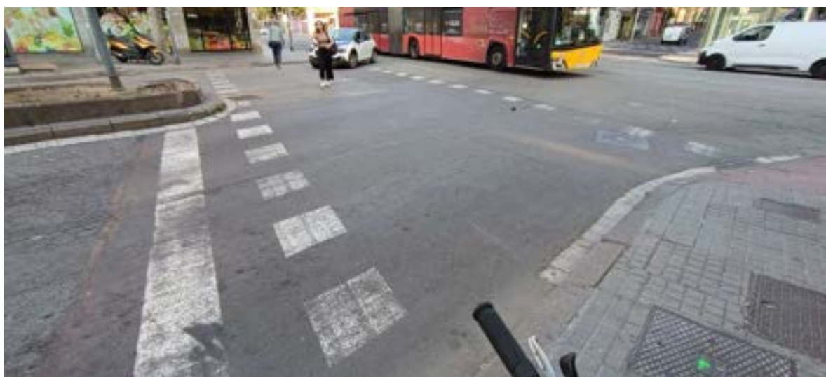
Vista Pas de zebra previ a cruïlla – Zones ja asfaltades on realitzar talls previs al fressat.
