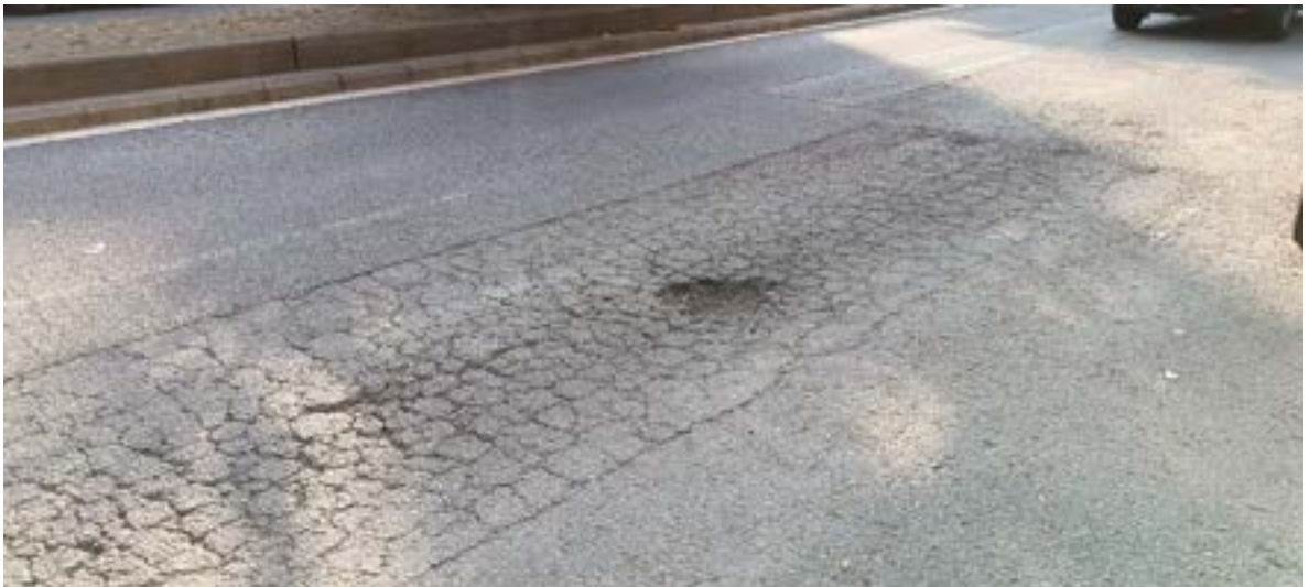
Costat sentit St. Adrià - Estat del ferm general a alçada pistes esportives i detall flonjall.
