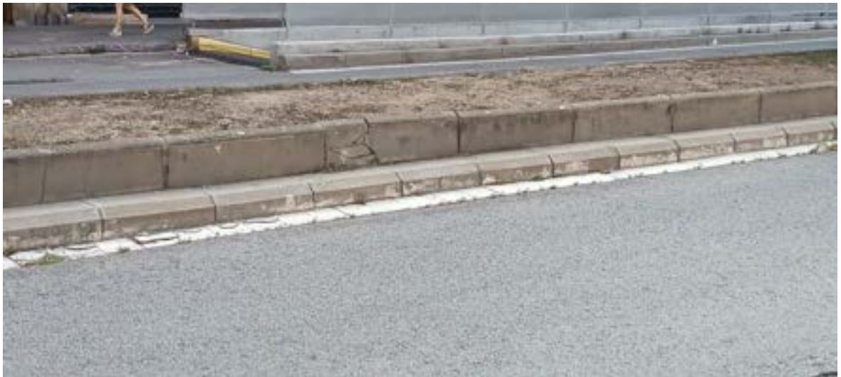
Detall peça malmesa vorada a reposar marcada en foto pàgina anterior. – Estat general ferm
