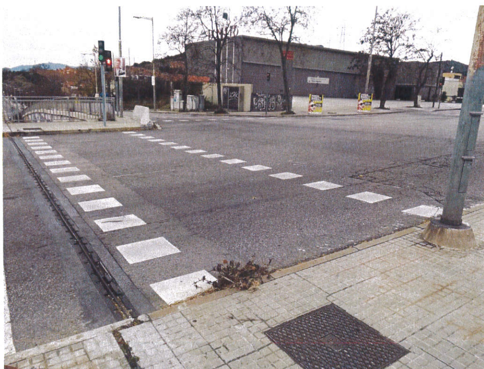
Vista general sobre pont de B-20
