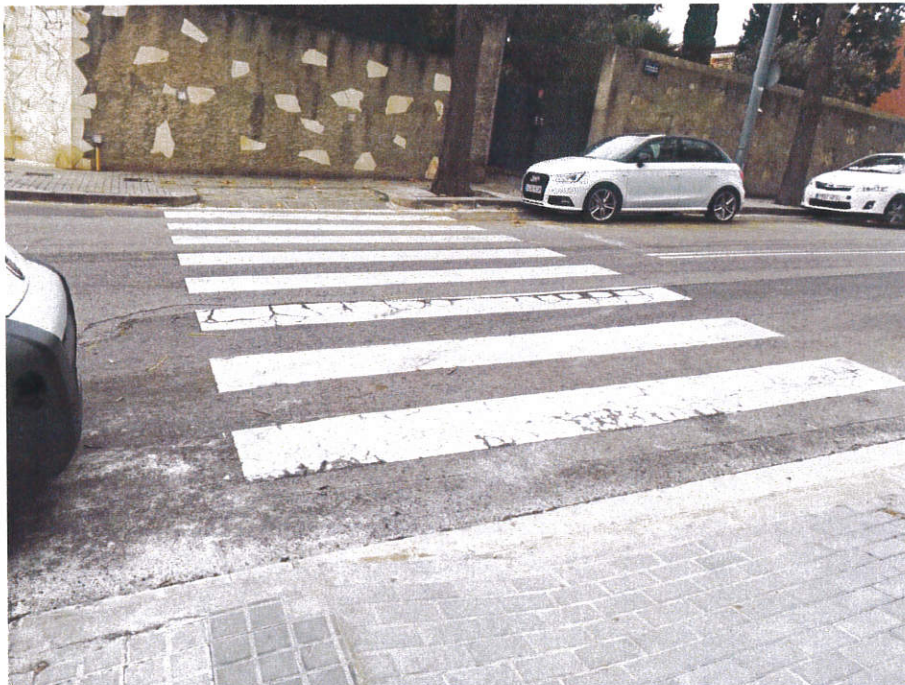
Vista costat muntanya part que s'elimina
