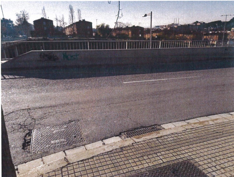
Costat mar nova ubicació
