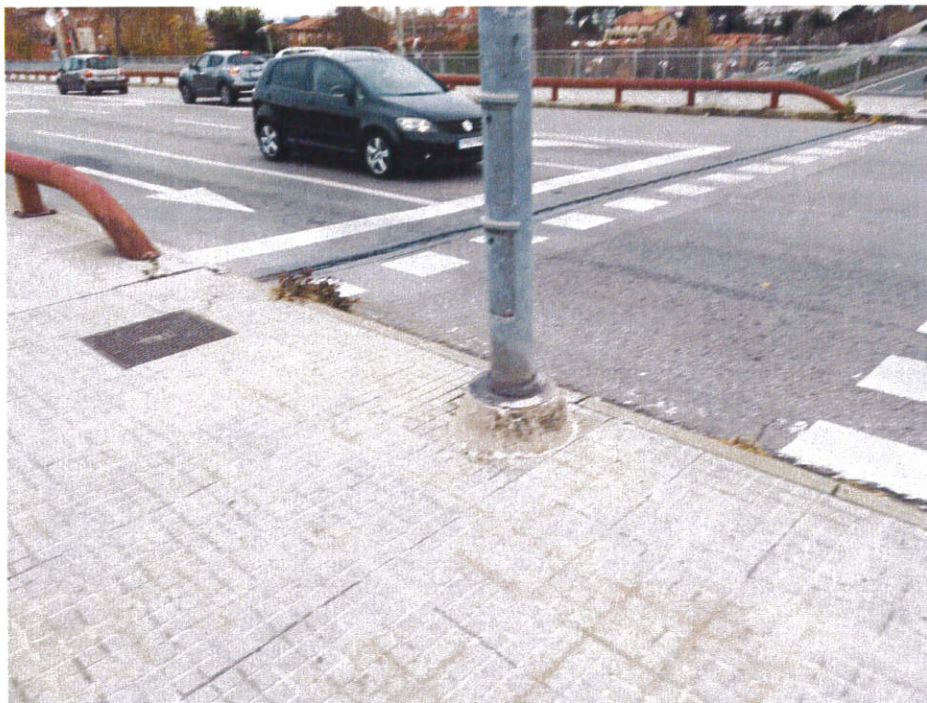
Costat Mataró sobre pont de B-20
