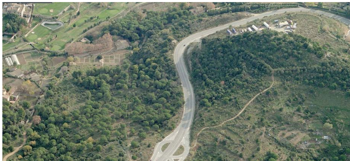
Fotografia aèria de l'àmbit de Can Cabra
