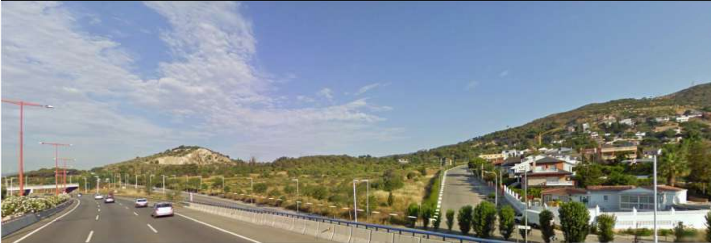
ESTAT ACTUAL VISTA 1
