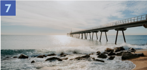
Pont del Petroli / Punto del Petróli / Petroli Pier / Pont del Petroli
