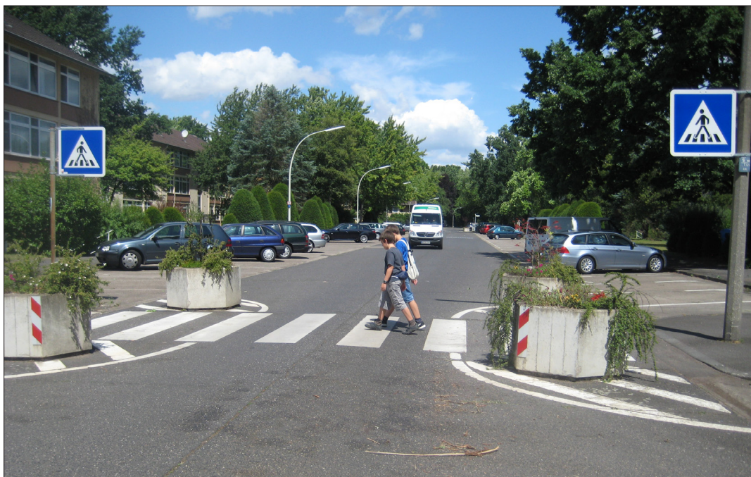
Creació d'orelles sense obra civil
