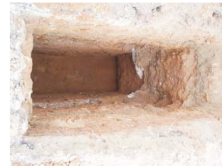
Detall de l'estabilitat de les parets de la cala.
