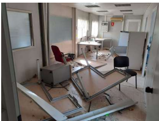
Vista general de l'estat interior del mòdul.
