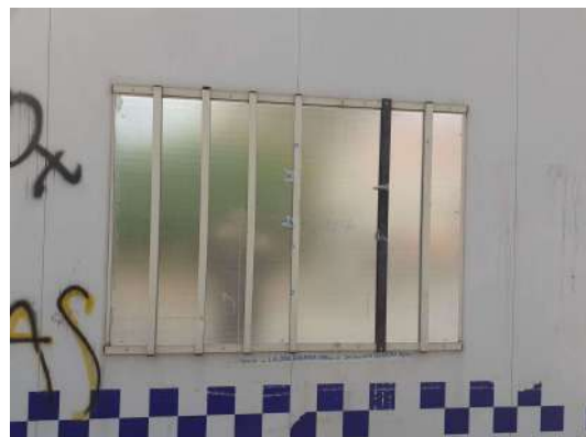
Xapa per protegir inexistència de finestra.
