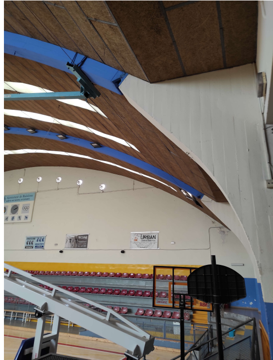
La Plana – Fals sostre existent
