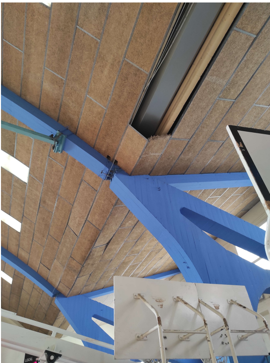
La Plana – Fals sostre existent
