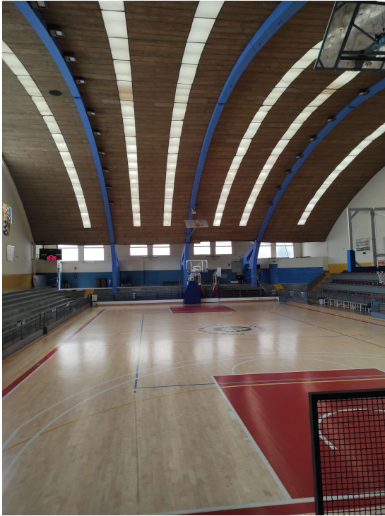
La Plana – Fals sostre existent
