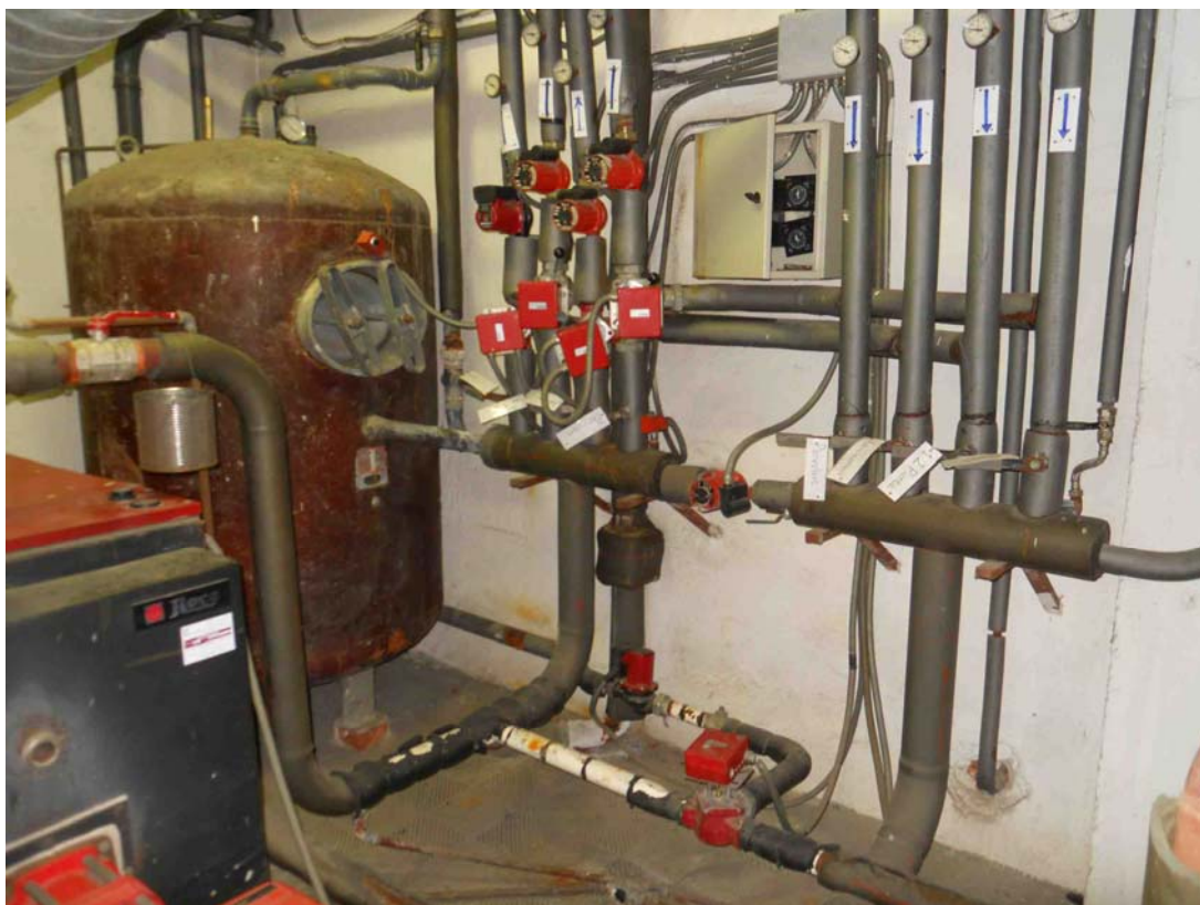
Circuits de calefacció i sistema ACS.
