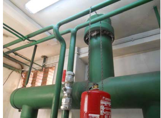
Circuits de calefacció i col·lectors d'extracció de fums
