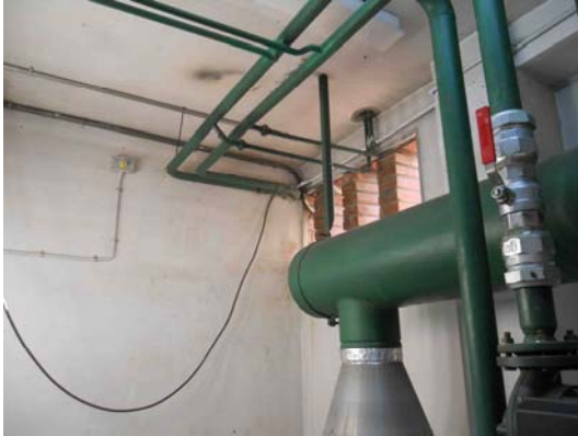
Circuits de calefacció i col·lectors d'extracció de fums
