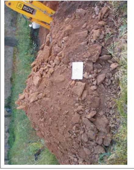
Vista del material excavat a la cala
