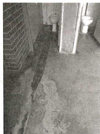
Paviment i pas d'instal·lacions
