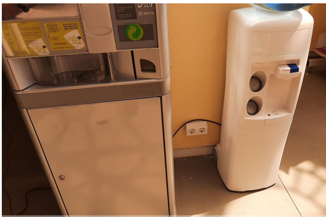
Imatge 3 – endolls de la cafetera i la màquina d'aigua que no funcionen
