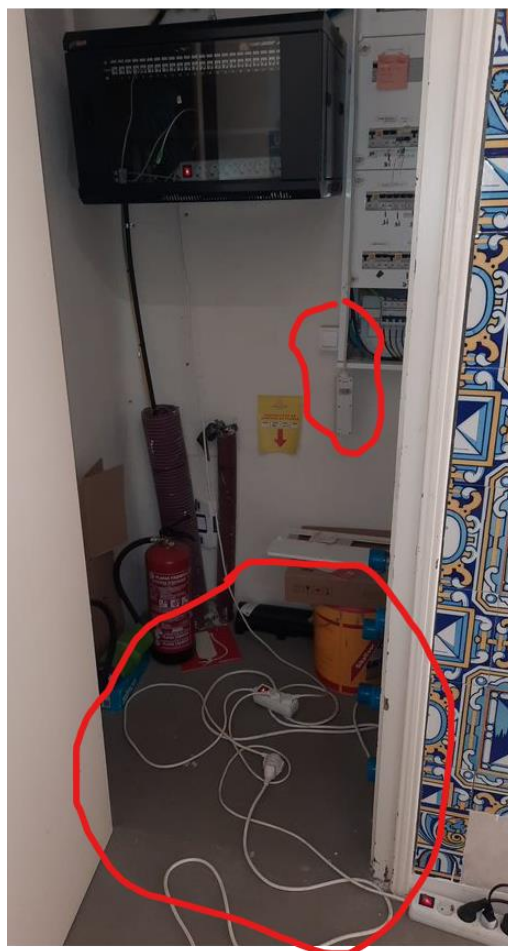
Imatge 2 – endolls penjants sense funcionar, distribució d'endolls per terra i amb lladres
