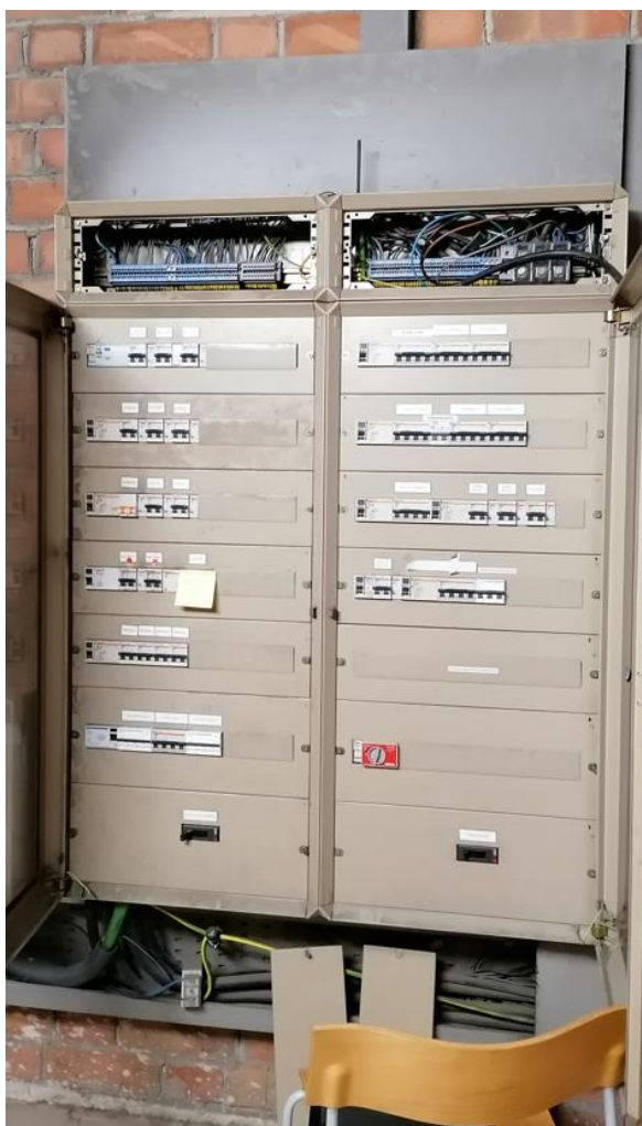
Imatge 3 – Quadre general, falten col·locar tapes i tapar les canalitzacions
