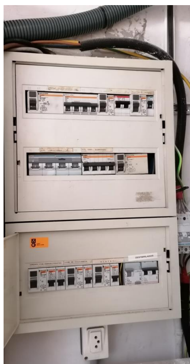
Imatge 3 – Quadre general de baixa tensió i endoll no homologat
