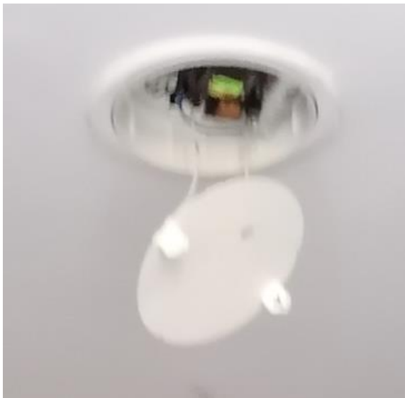
Imatge 7 – downlight sense llum i amb la placa penjant
