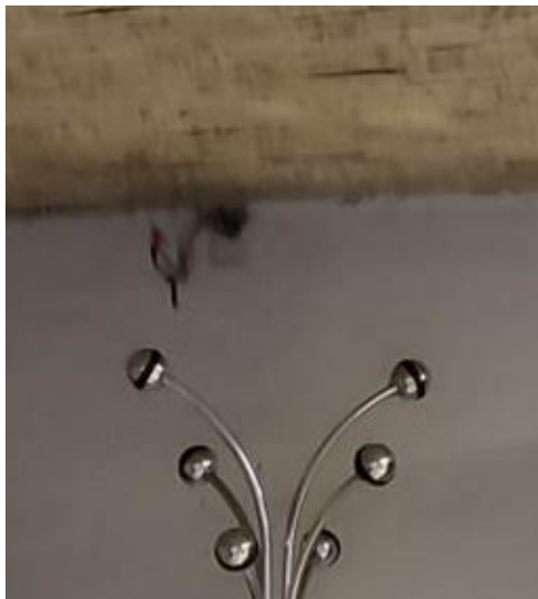
Imatge 3– exemple cables en punta
