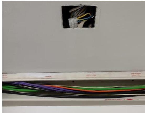
Imatge 6 – caixetins sense tapa i canalització oberta sense tapa
