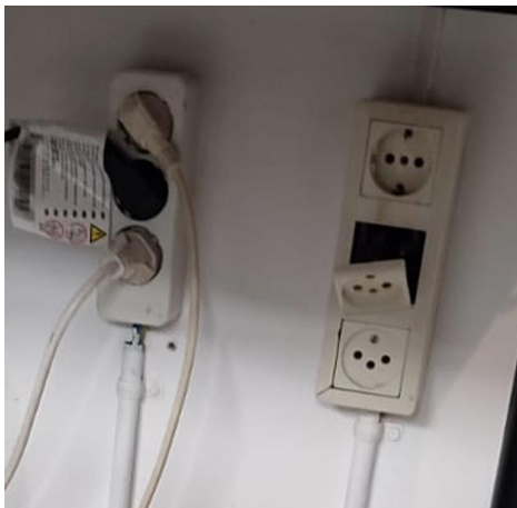
Imatge 11 – endolls penjant o en mal estat
