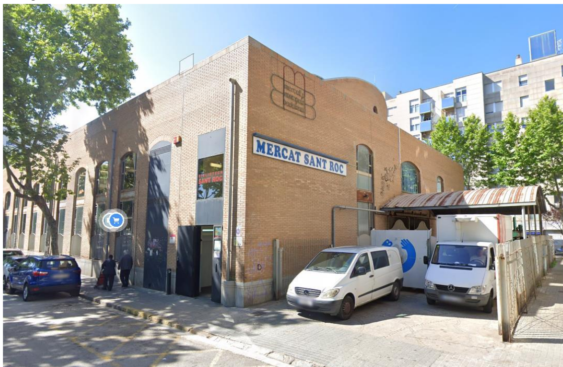
Fotografia 2. Façana intervenció Biblioteca.
