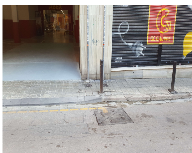
Fotografia 6_Estat actual – Àmbit 1
