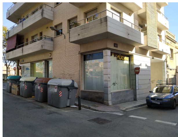
Fotografia 6_Estat actual – Àmbit 2
