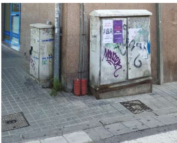
Fotografia 5_Estat actual – Àmbit 1
