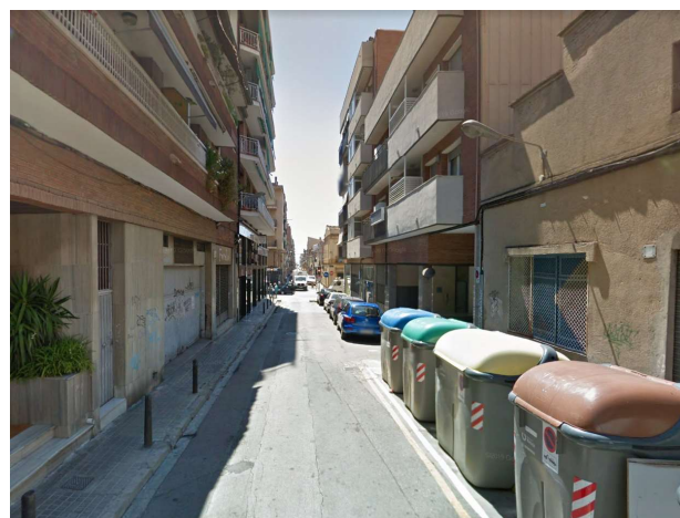
Fotografia 4_Estat actual – Àmbit 1
