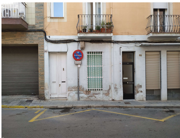
Fotografia 5_Estat actual – Àmbit 3
