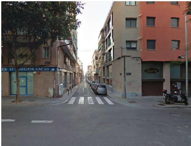
Fotografia 1_Estat actual – Àmbit 1
