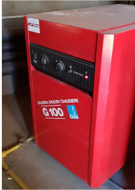
Figura 1. Caldera de les instal·lacions existents
