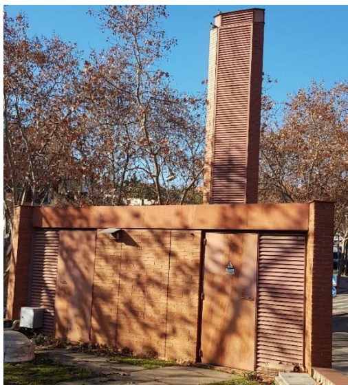
Figura 8. Ventilació existent a la sala de màquines actual
