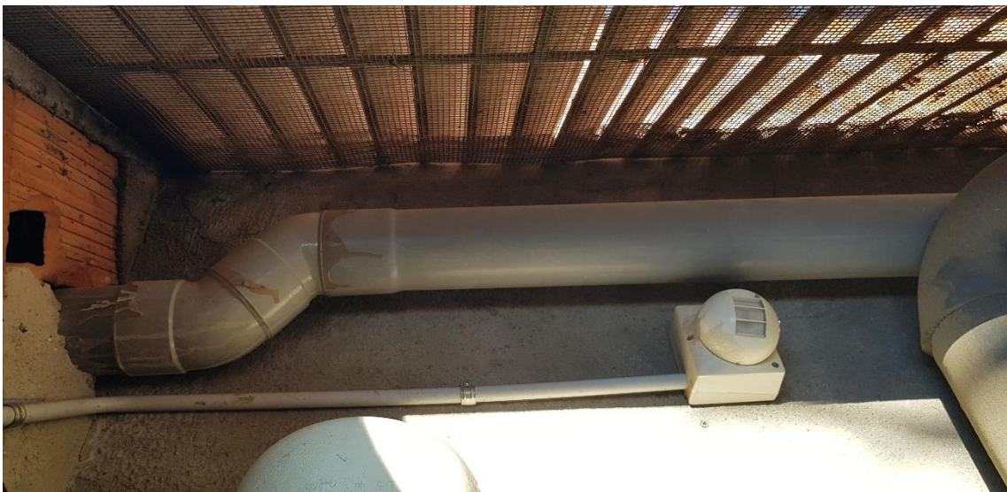
11.1.18. Paret dèbil existent
