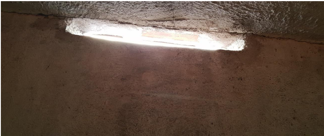
11.1.20. Orifici inferior existent
