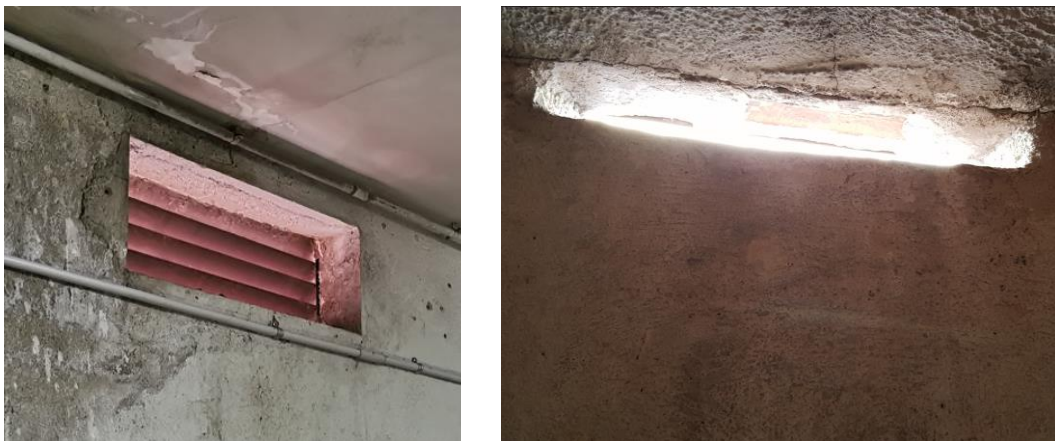
Figura 5. Ventilació existent a la sala de màquines actual
