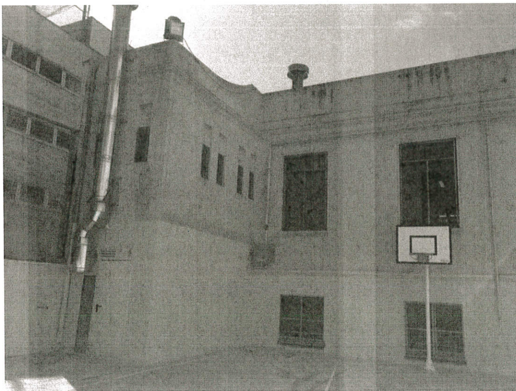
Façana lateral a pati
