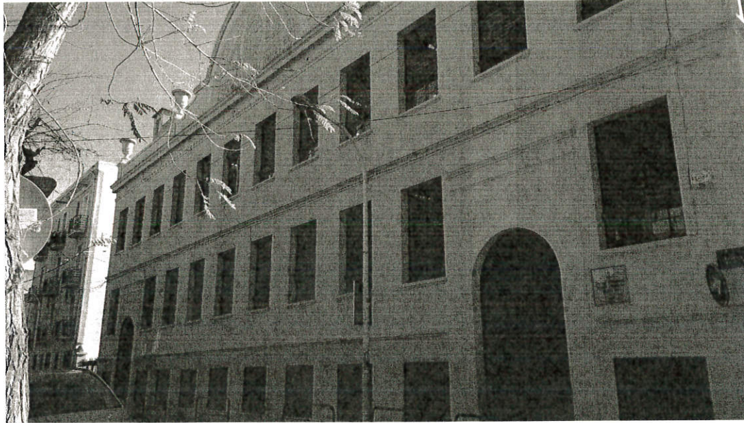
Façana principal passatge Ventós Mir
