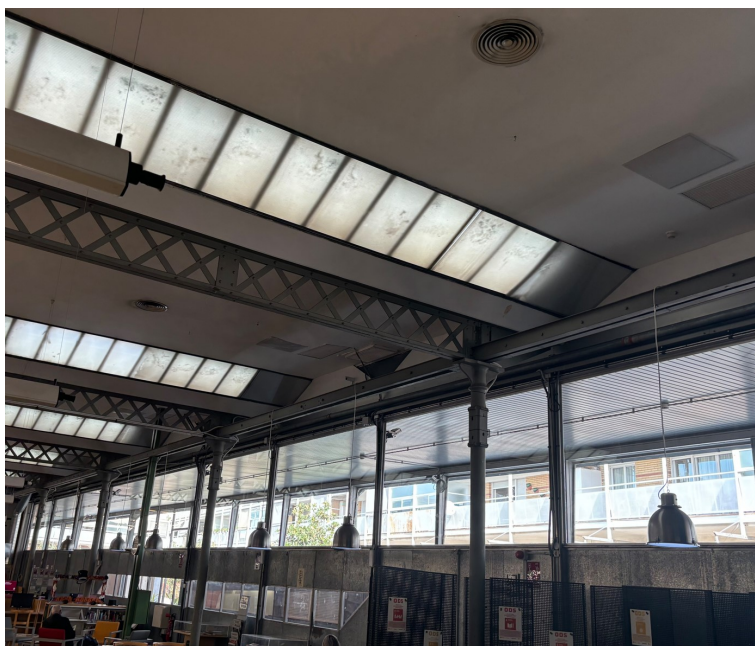
Ubicació fancoils existent a fals sostre biblioteca
