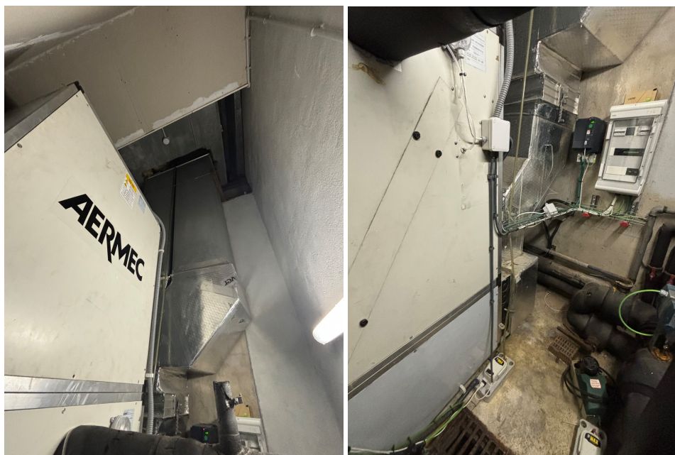
Estat actual sala CL3
