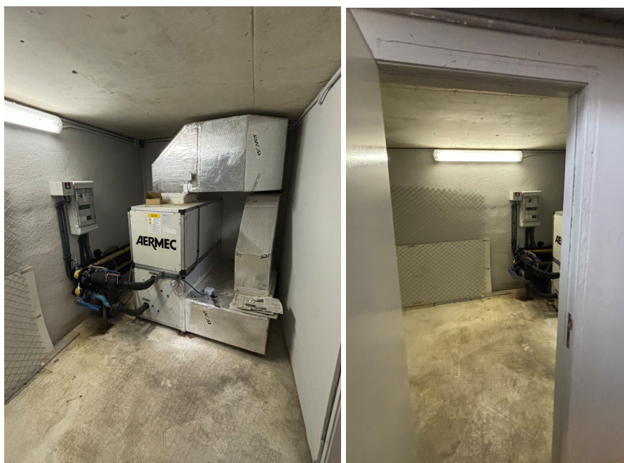
Estat actual sala CL2
