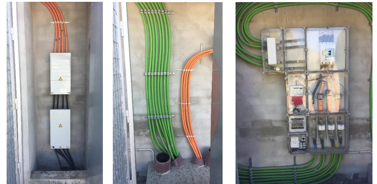
Figura 7. Detall Armaris de Comptadors
