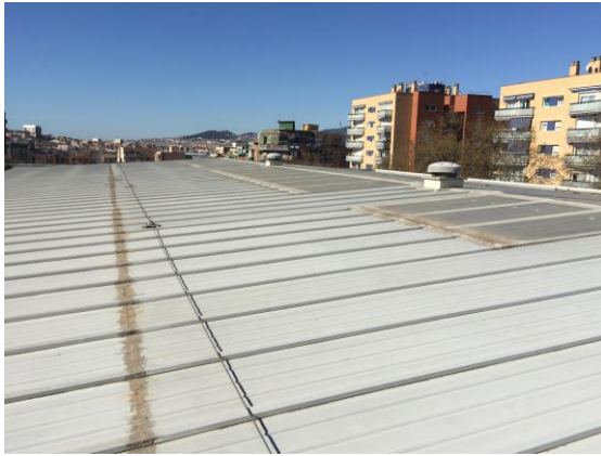
Coberta Sud – Est Pavelló
