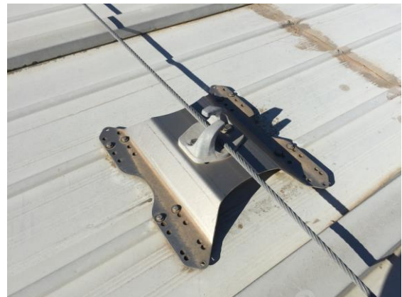
Detall fixació línia de vida existent
