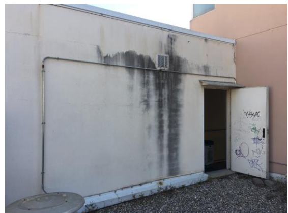
Paret Sala de Calderes on col·locar quadre PV
