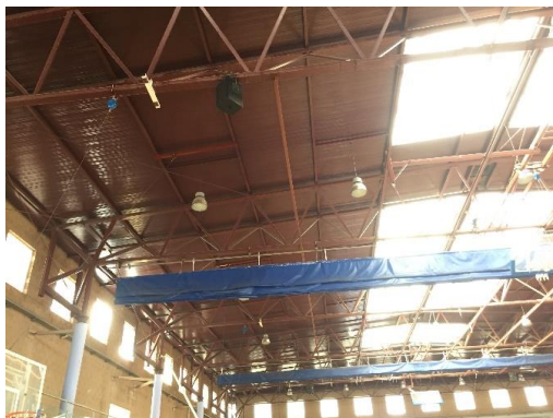
Figura 3. Estructura i coberta Pavelló Poliesportiu Montigalà
