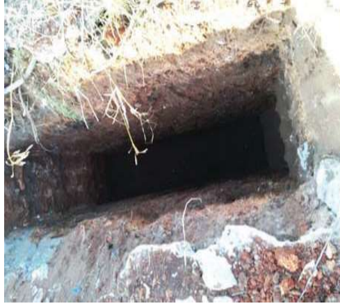
No se alcanza el nivel freático.
