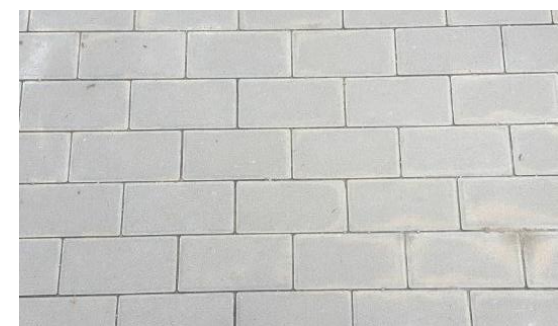
3_Paviment de llambordes BREINCO model Terana Six de 20x10x8 cm col·locat a trenca junta i sobre base de formigó i terra compactada.
