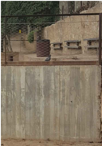
Imatge mur i barana MUR 2
