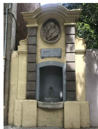
1_Font existent en el mur del carrer Sant Bru. Es traslladarà integrant-la a l'edificació existent conservant l'imatge
