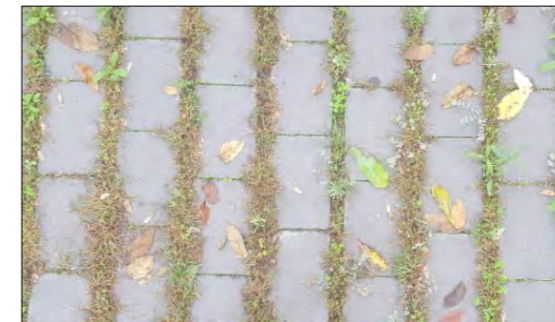
2_Paviment d'exterior TERANA GREEN de BREINCO amb junta verda i format 20,8x11,8x7 cm
