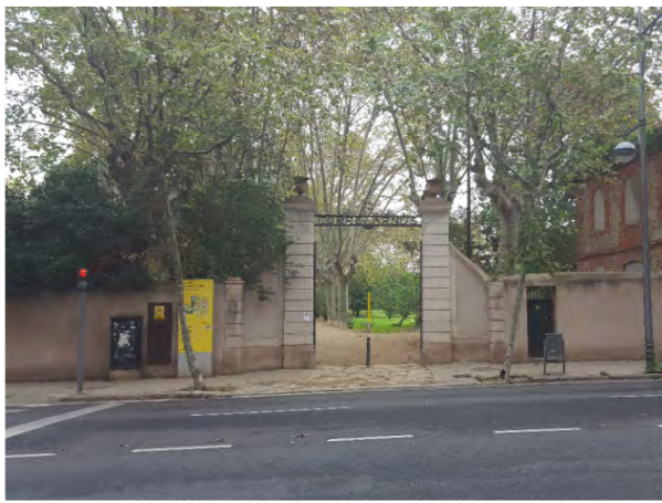
2_Mur i portalada d'accés existent a conservar
