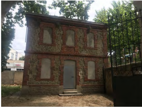
3_Edificació existent a conservar.
