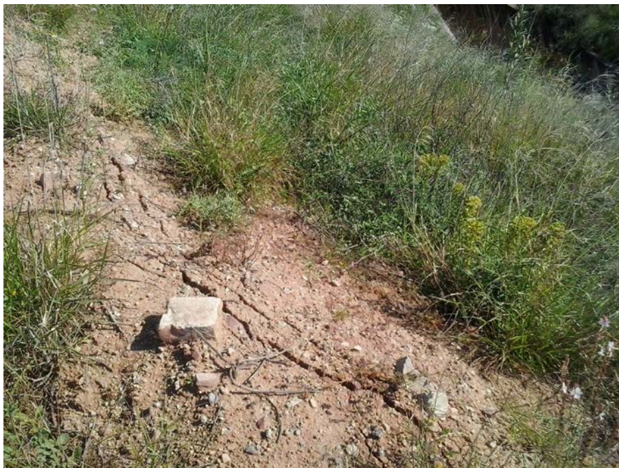
Erosió local al cap del talús superior
