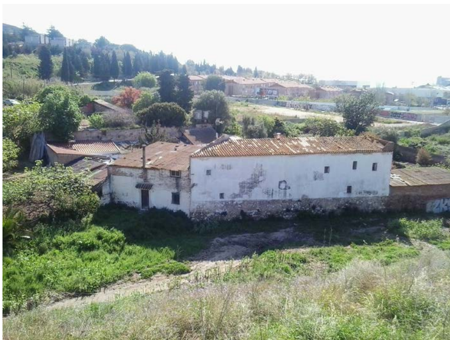
Edificació existent al mig del torrent
