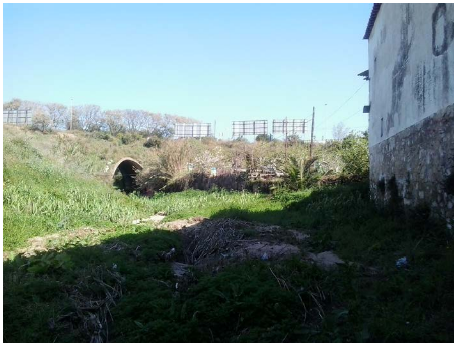
Vista de la llera del torrent
