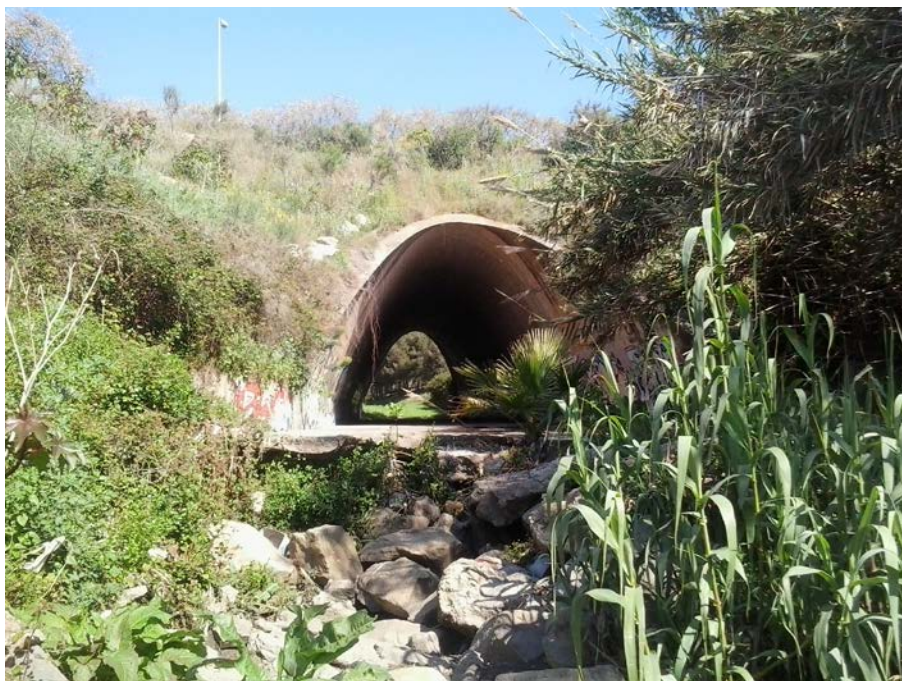
Obra de fàbrica sota l'Av. de la Cerdanya, a l'inici del sector estudiat
