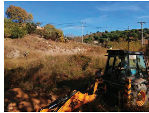
Foto 66. Vista general de la parcela al sur de la c. El Canyet.
