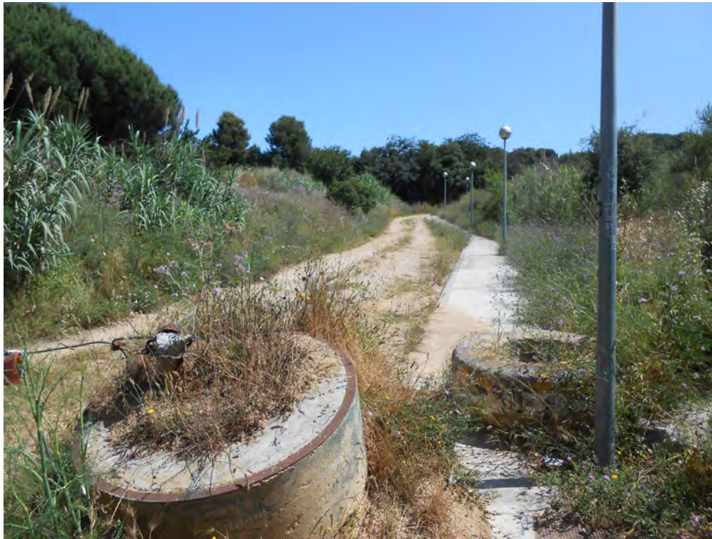
Foto núm. 5:- Eix 1 (pk 0+420 aprox)
