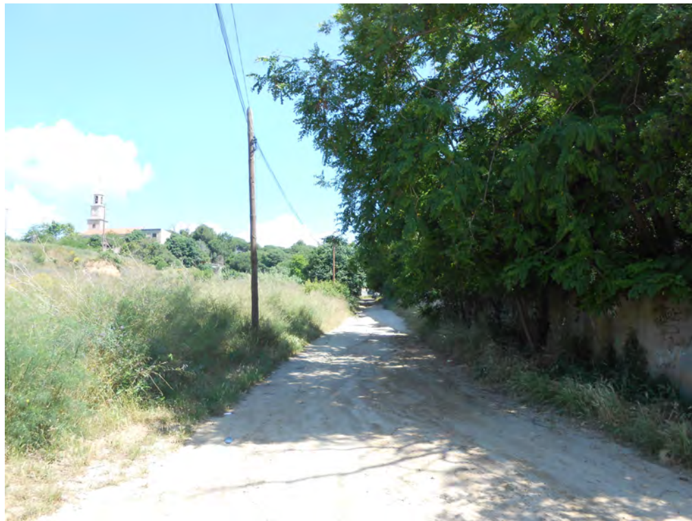
Foto núm. 2:- Eix 1 (pk 0+700 aprox)
