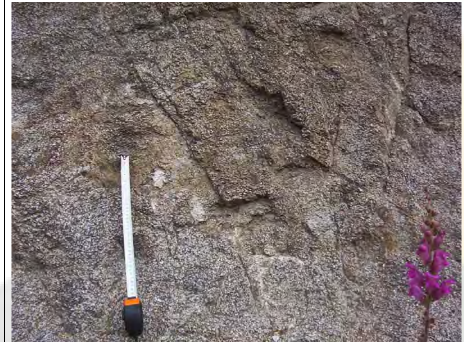
Foto 55: Detalle de diaclasas del talud inferior
