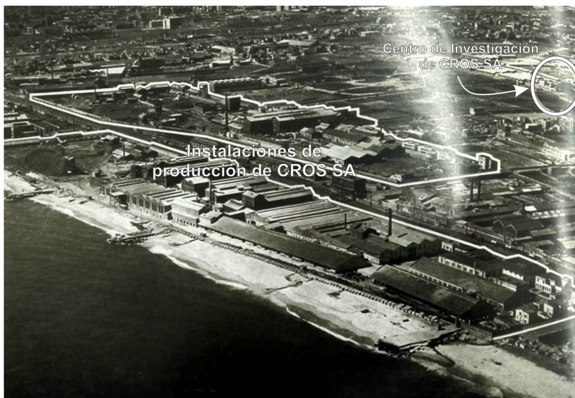
FIGURA 2. Vista general de las instalaciones de CROS SA en 1965 (Fuente: Museo de Badalona).
