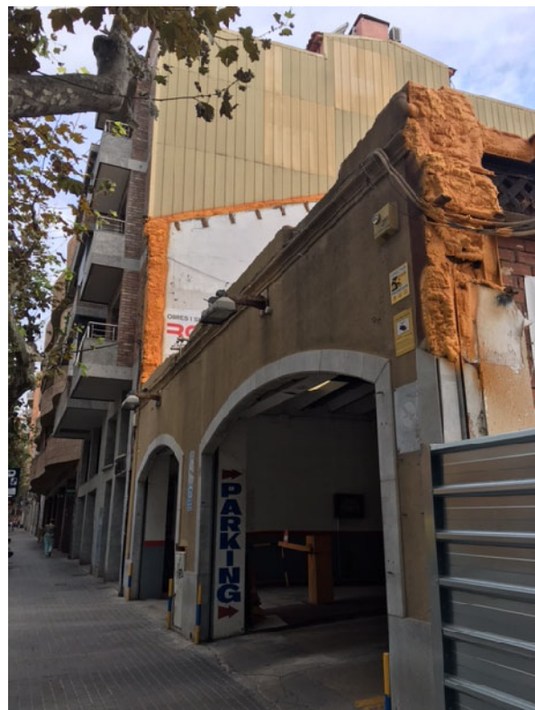
Edificació a enderrocar al carrer Prim 77-79
