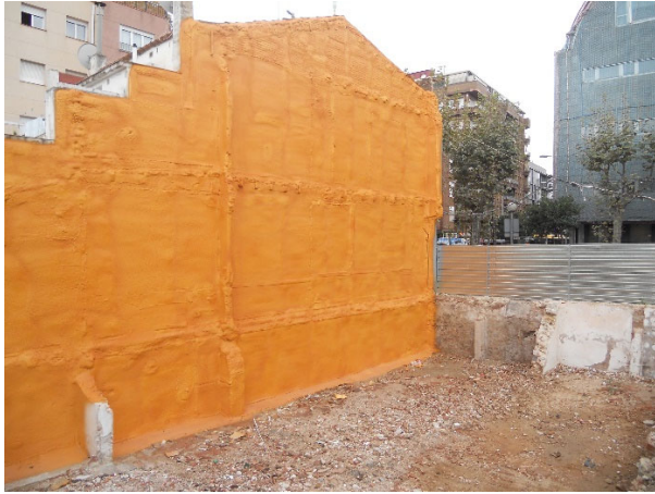
Edificació a enderrocar al carrer Prim 67
