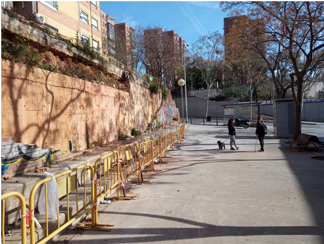
Fotografia nº2: Vista mur al carrer Venezuela
