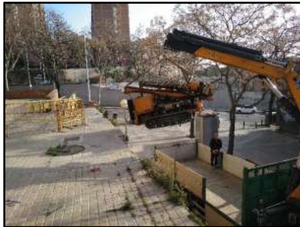
A dalt, fotografia amb el transport de la màquina de sondeigs des del carrer Veneçuela fins l'esplanada d'estudi, mitjançant un camió-ploma.
