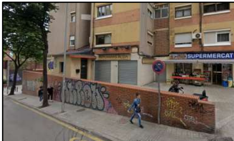
Panoràmica del tram de mur de contenció de terres de l'avinguda del Doctor Bassols, on s'observa l'increment d'alçada en direcció al carrer de Veneçuela (a l'esquerra), atès el pendent de l'avinguda.
