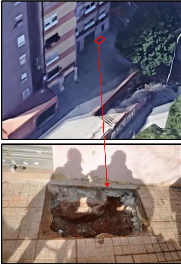
Emplaçament i detall de la cala de reconeixement oberta tocant a l'edifici per a l'observació de la fonamentació.
