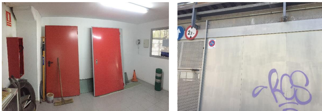
Figura 9. Detall Sala Rack
