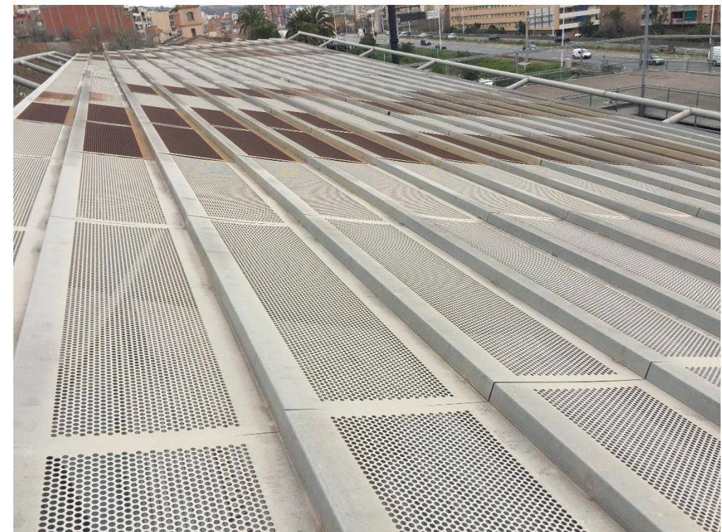
Xapes perforades de la coberta de la Pèrgola on s'instal·larà el camp fotovoltaic
