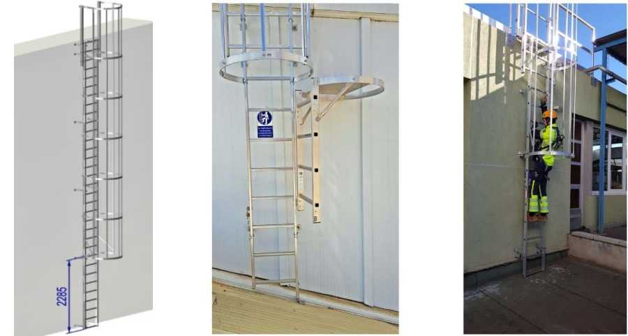
Figura 6. Detall Escala d'accés fixa de manteniment
