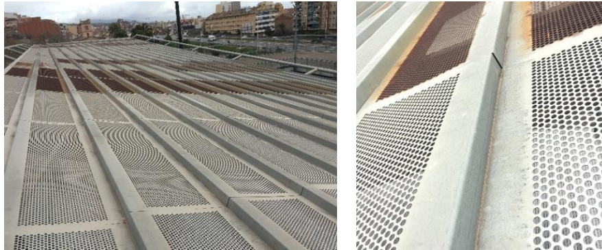
Figura 8. Detall planxes de la pèrgola oxidades
