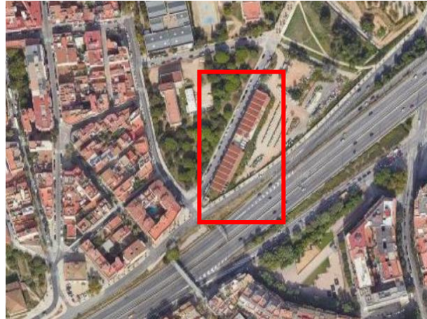
Figura 1. Vista general emplaçament
