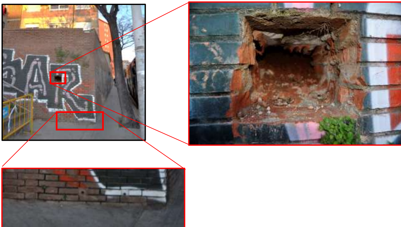
Vista d'emplaçament i de detall de la cala efectuada en el tram de mur de contenció de terres paral·lel al carrer Veneçuela. La fotografia inferior mostra uns petits drenatges que la part basal del mur.
