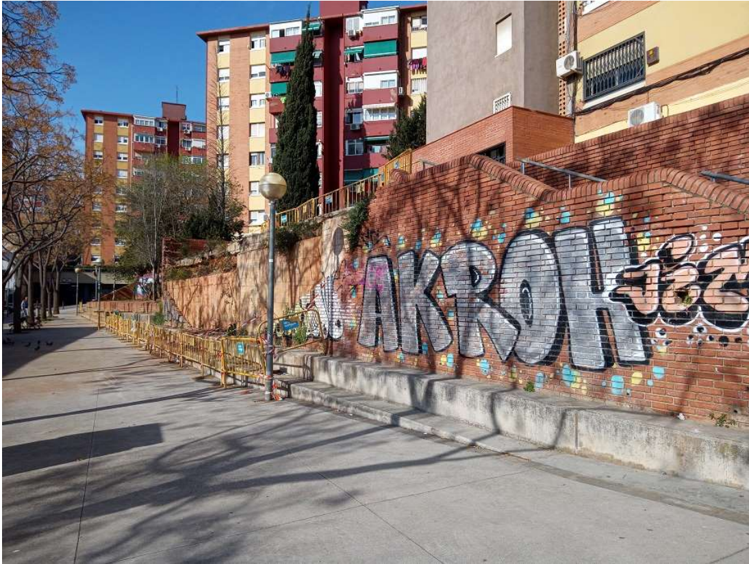
Fotografia nº1: Vista mur escala al carrer Venezuela.
