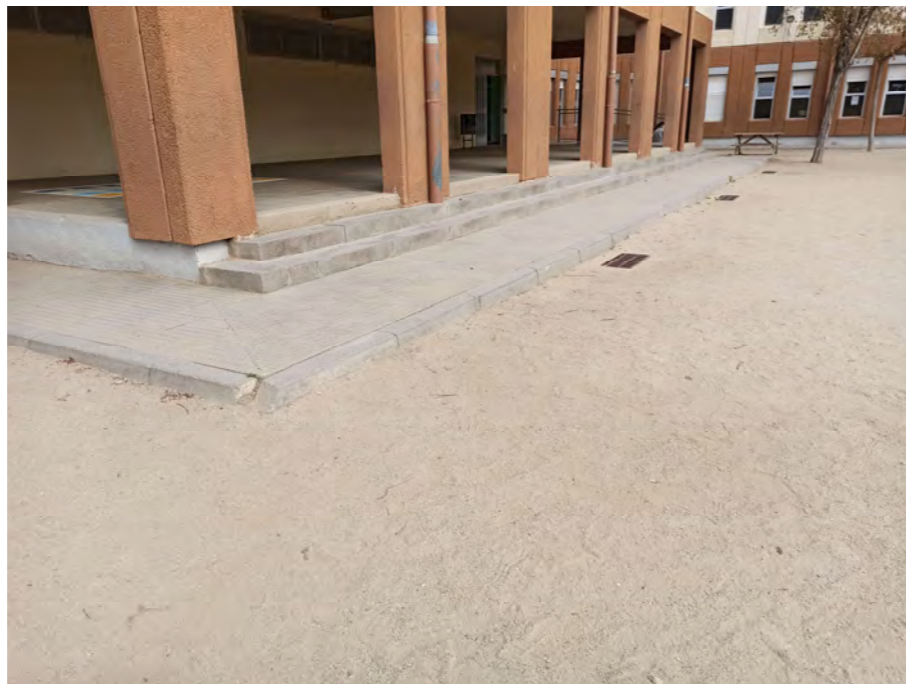
FOTOGRAFIA 10: Zona Plaça entre Edificis Escola. Línia Embornals
