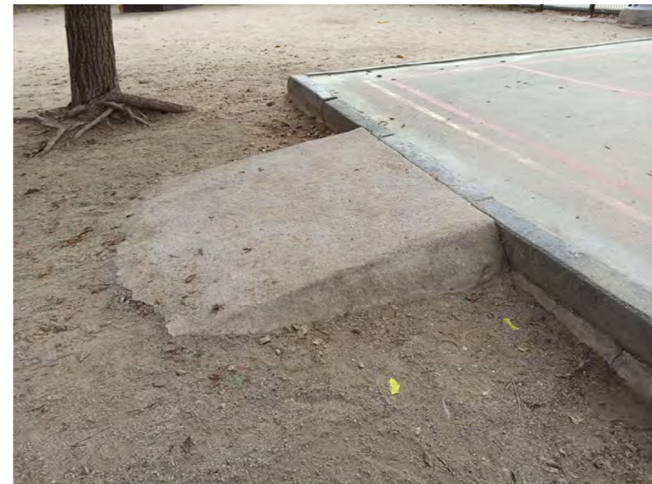
FOTOGRAFIA 16: Rampa Accés Pista Futbol
