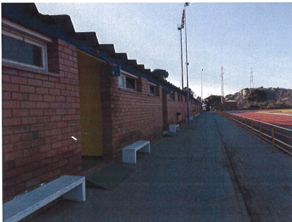
Vista general exterior del cos de vestidors i lavabos.
