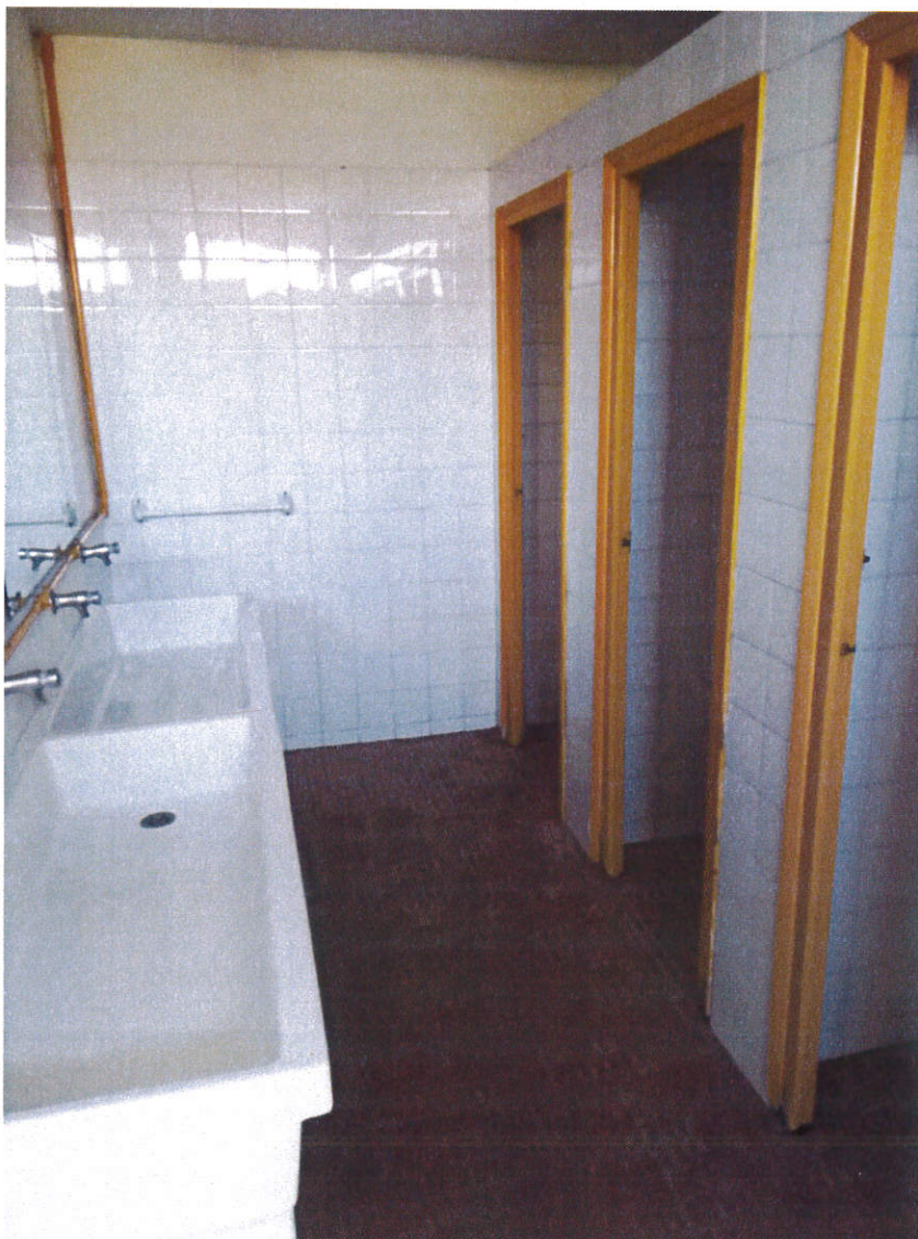
Vista general lavabos dones
