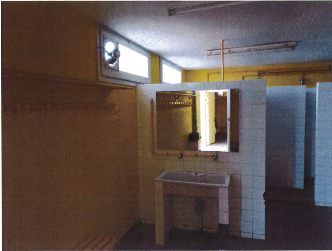
Vista general de l'interior dels vestidors
