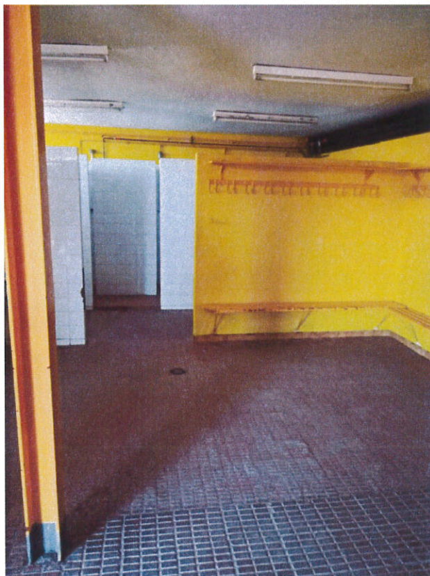
Vista general de l'interior dels vestidors
