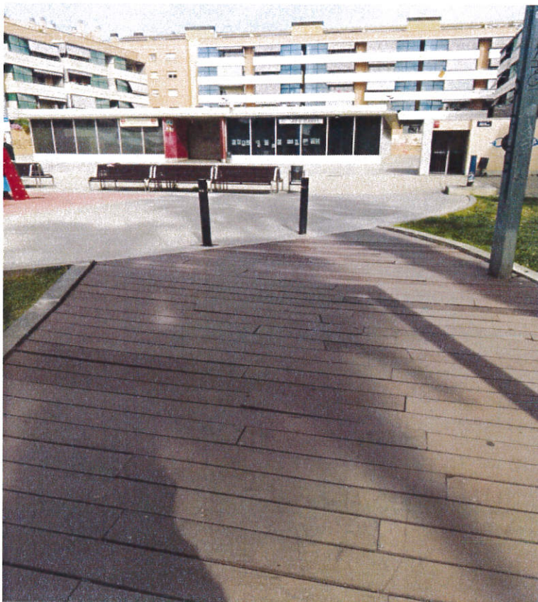
Vistes de la rampa en el seu estat actual
