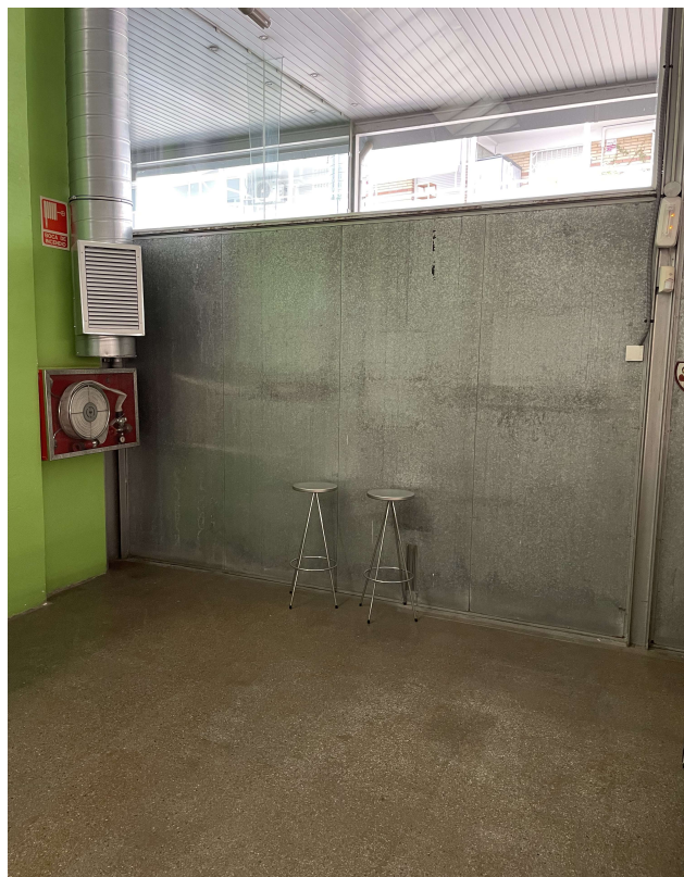
Nou accés a Infantil – Tancament a demuntar
