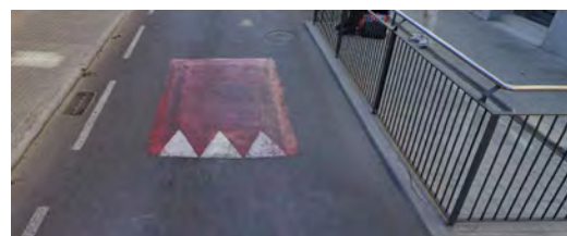
Exemple coixí berlinès d'asfalt realitzat a C/ Enric Borràs de Badalona.
