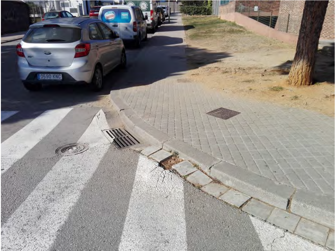
Aixecament d'un tram de rigola
