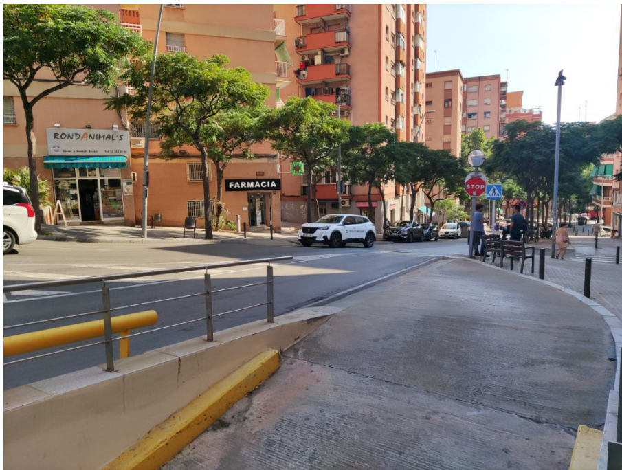
Detall de la sortida de l'aparcament privat soterrat
